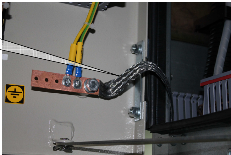
Рисунок 1- Заземление металлических частей шкафа.
