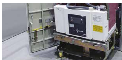
Выкатной элемент с выключателем HVX-40
