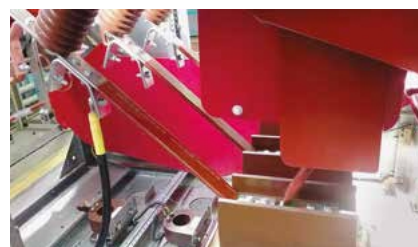
Отсек присоединений
